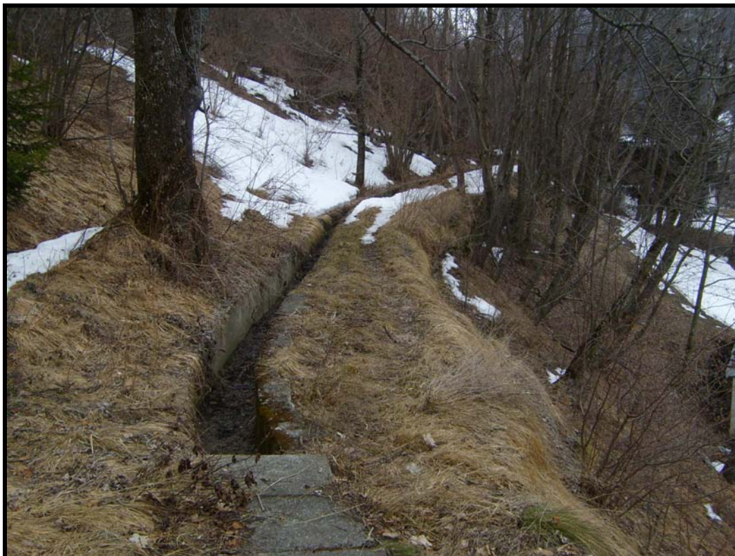
Foto 3 Canale irriguo a monte dell'abitato di Escarra
